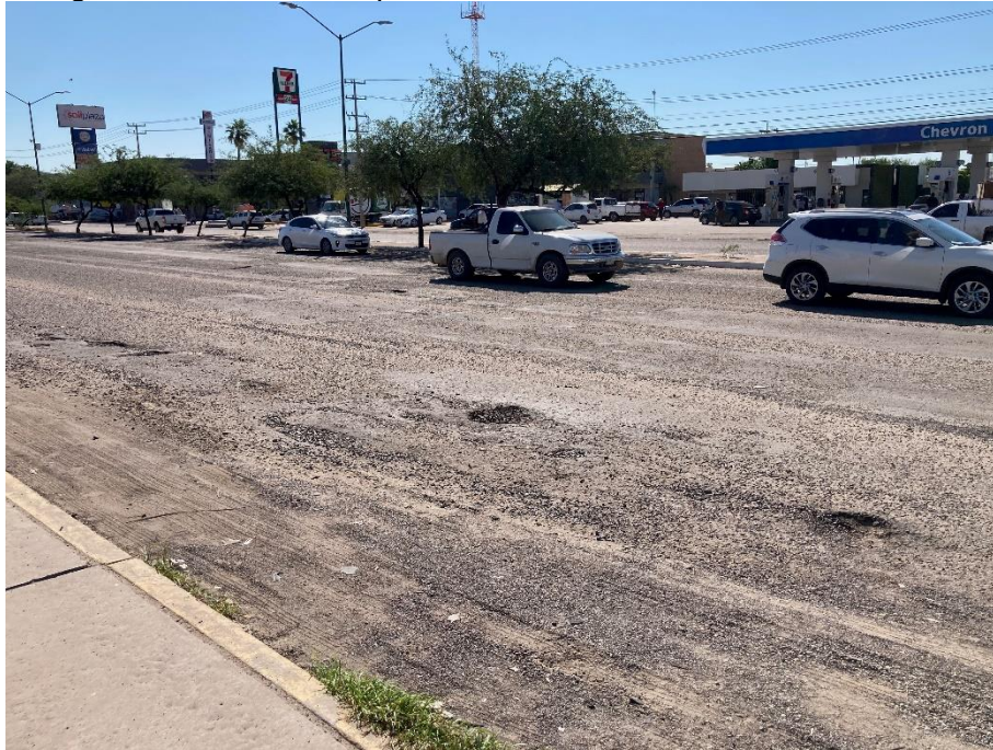
Figura 8.12 Estado del pavimento en blvd. Bautista de Escalante
