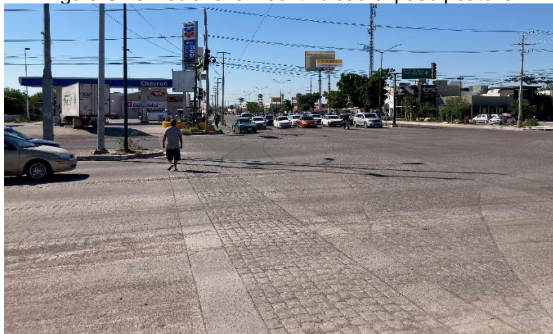
Figura 8.10 Mediana sin continuidad al paso peatonal
