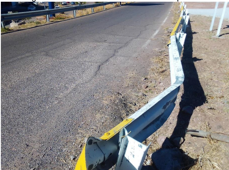
Figura 8.18 Barrera dañada en carril sur poniente
